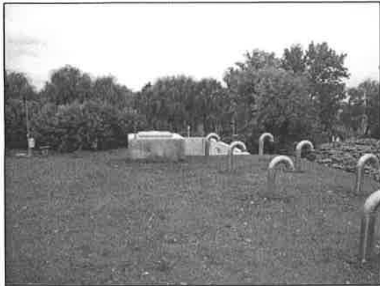
Nyersvíztároló és szűrtvíztároló medence
