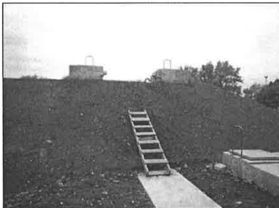
Nyersvíztároló és szűrtvíztároló medence környezet
