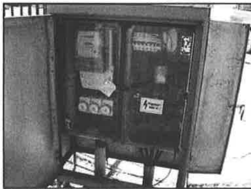
32. kép: DÁ-M-IV-es átemelő - elektromos szekrény
