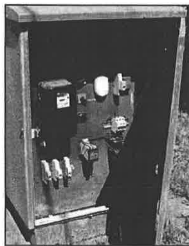
21. kép: DA-M-II.-es átemelő - elektromos szekrény
